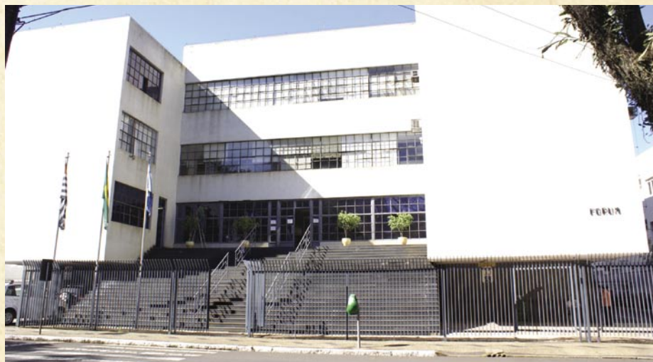
Atual prédio que abriga o Fórum da Comarca de Rio Claro
