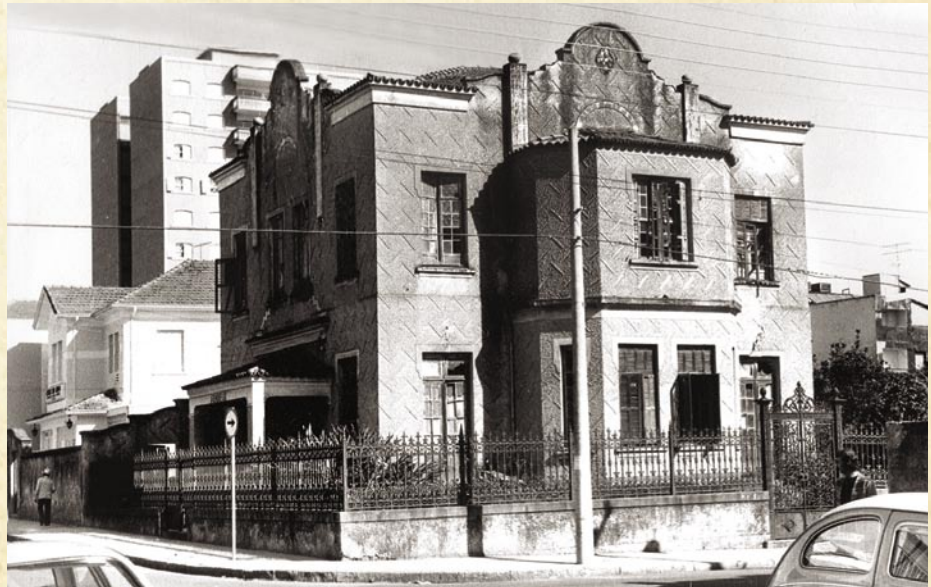
Prédio da Avenida 2, com a Rua 5, demolido em setembro de 1979
