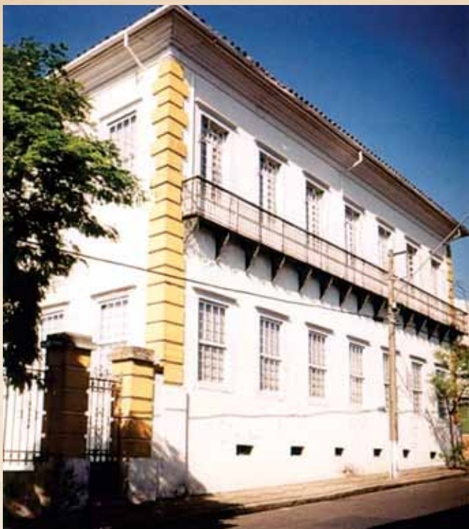
Vista da fachada lateral. Notam-se as características de um casarão eclético – com porões e gradis de ferro, janelas guilhotinas, beirais e a imitação em pedra de cantaria. Acervo da autora: Novembro/2002
