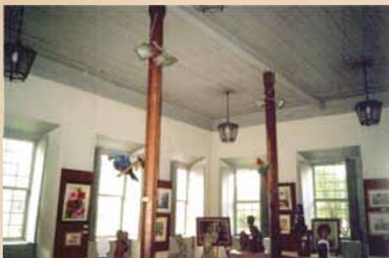
Sala de Exposição Temporária. Detalhe do forro saia-e-camisa, dos colunelos de madeira e das aberturas das janelas. Acervo da autora: Agosto/ 2002
