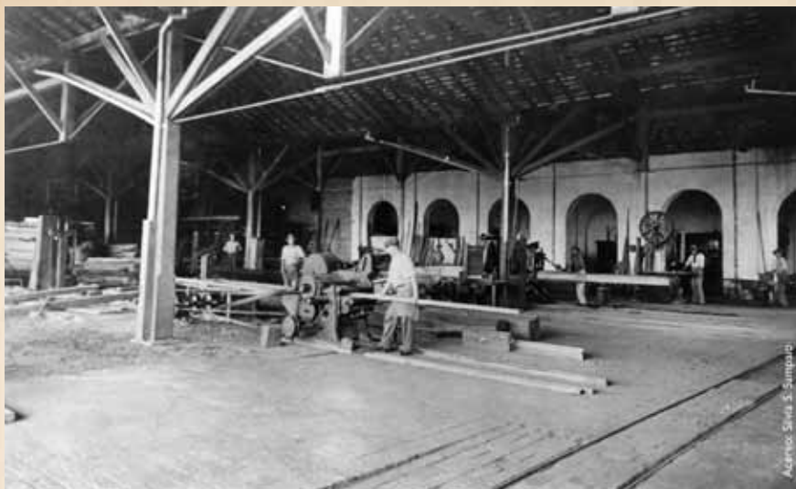
Trabalhadores no interior da serraria da "Casa Augusto Schmidt", à rua 1, avs. 3 e 5. Data: década de 1940.
