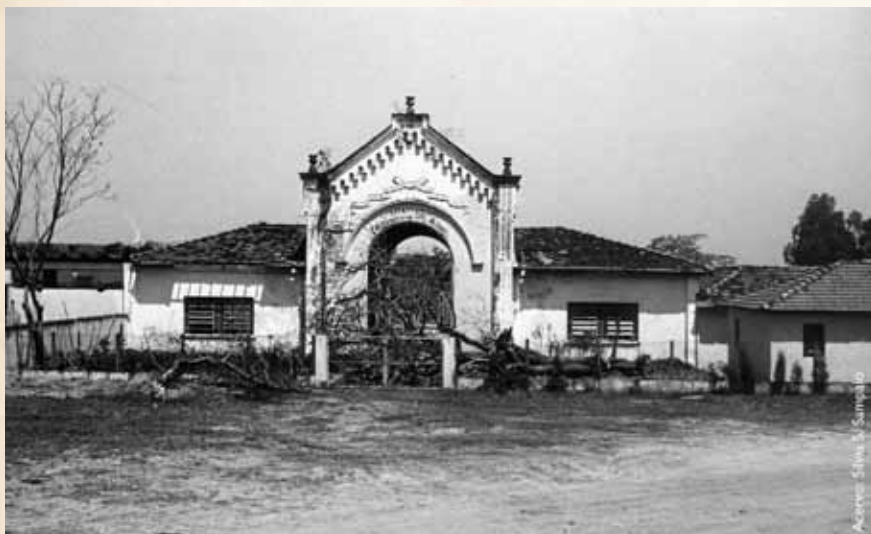
Instalações do extinto Matadouro Municipal, já com as janelas modificadas. Data: 1992.
